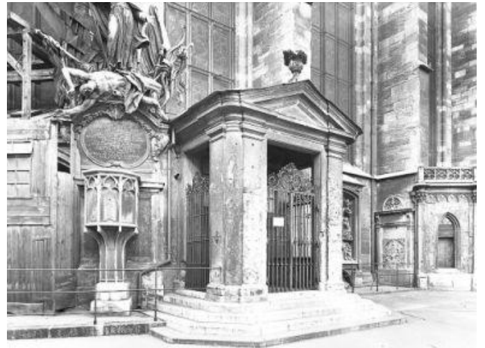
Stephansdom mit der Totenkapelle neben der Capistrankanzel (Aufnahme in den 40er Jahren des 20. Jhs.)
